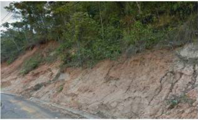
Foto 017 – Escorregamento de massa a montante da Estrada do Cantagalo.
