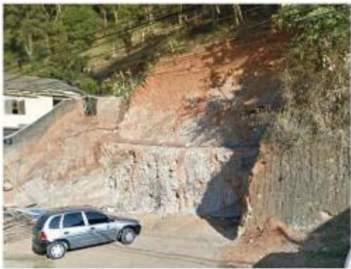
Foto 004 – Corte inadequado e deficiência de drenagem.
