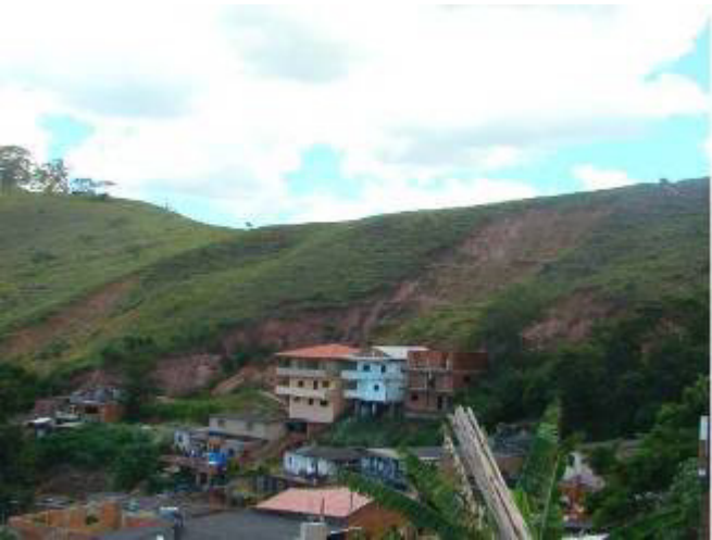
Foto 027 – Avanço da ocupação, com execução de cortes inadequados desencadeando processos erosivos na encosta.
