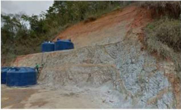
Foto 052 – Corte e deficiência de drenagem no talude.
